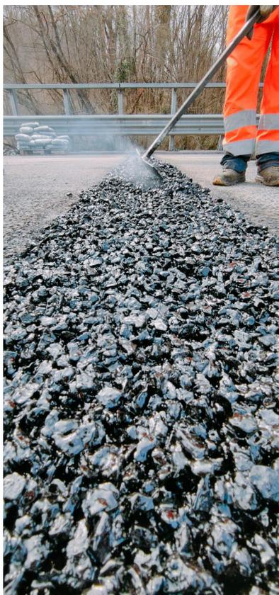
Mastice bituminoso ad alte prestazioni per la posa di giunti di dilatazione a tampone e la sigillatura di lesioni su pavimentazioni rigide o flessibili
